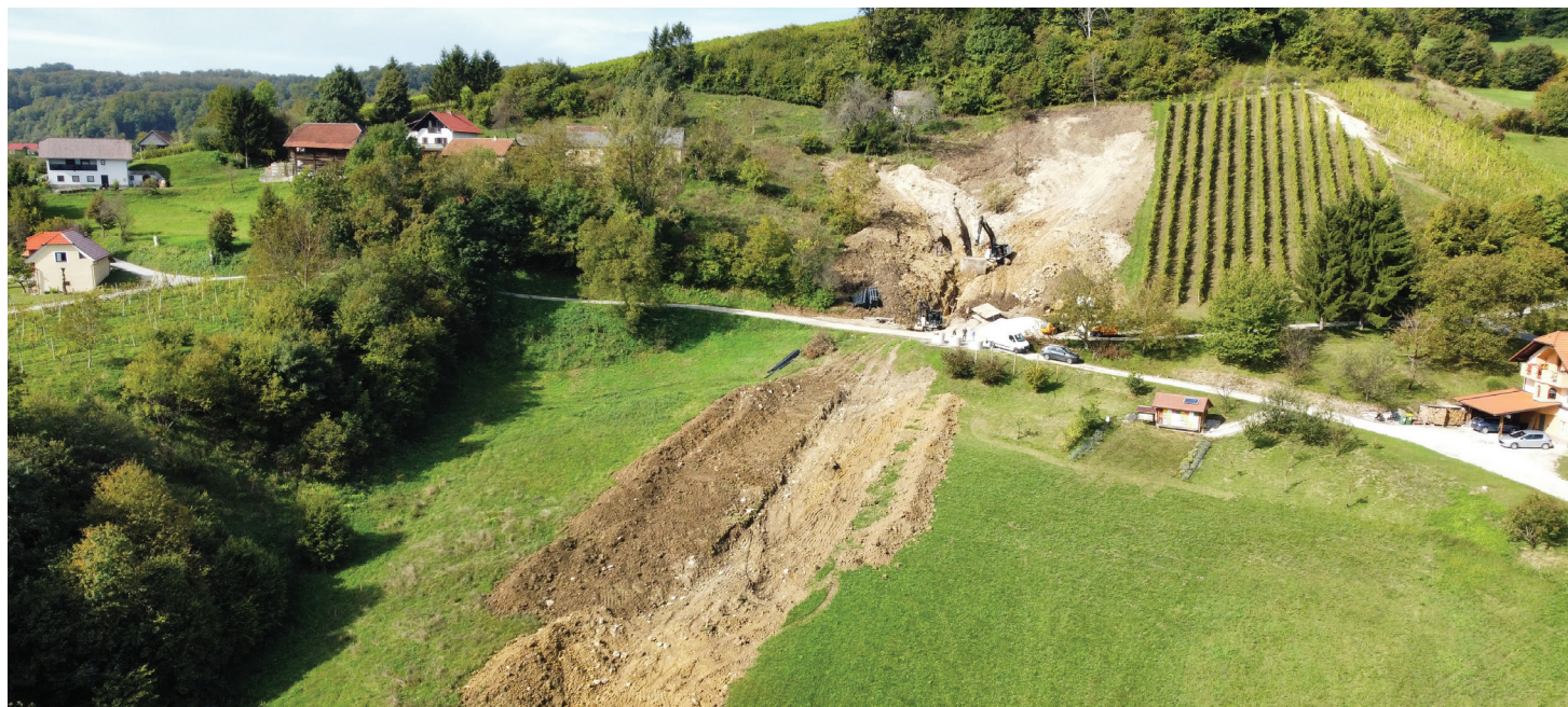
Plaz v Srebrniku bodo začeli sanirati v kratkem, dela na plaz v Črešnjevcu pa potekajo s polno paro.
